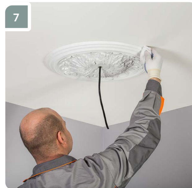
7 При необходимости места примыкания изделия к потолку протереть ветошью, смоченной водой — при использовании клея «Европласт Монтажный» или ацетоном — при использовании клея «Европласт Универсальный».
